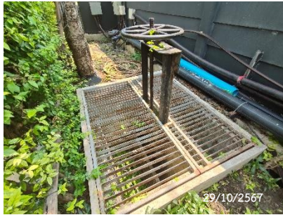
บ่อฟักน้ำก่อนปล่อยออกนอกโครงการ พร้อมตะแกรงดักขยะ
